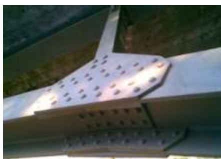
Obr. detail nýtované mostní konstrukce
